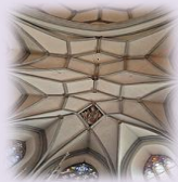
Gewölbe der Pfarrkirche Klausen. Foto: Dekan Georg Johann Martin
