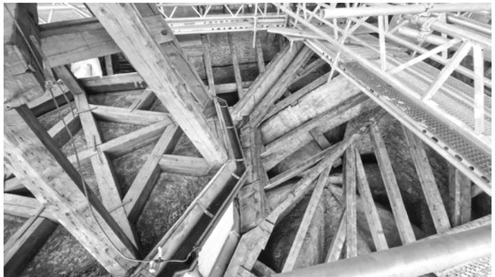
Am Seitenschiff über der Sakristei steht inzwischen ein neues Gerüst. Auch an dieser Stelle hat jahrzehntelanger Wassereintritt schwere Schäden an der Bausubstanz verursacht. Das Dach ist mittlerweile komplett entfernt. Der kleine Turm (Treppenaufgang auf die Nebenempore) sowie das Schrägdach vom Hauptgebäude müssen grundsaniiert werden. Nach der Schadensaufnahme beginnen hier nun die Zimmerarbeiten an den Holzkonstruktionen.
