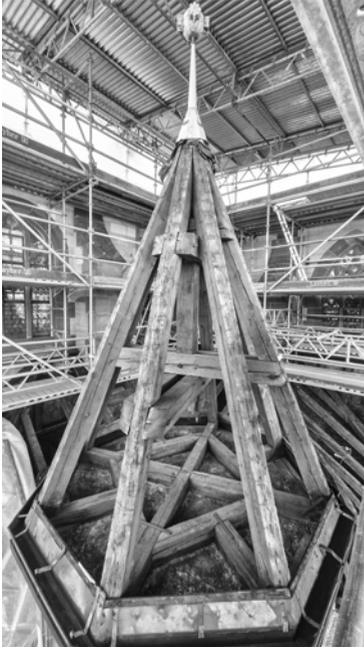
Seit Ende Mai wird das Baugerüst an unserem Kirchturm weithin sichtbar Etage für Etage zurückgebaut. Einige Restarbeiten werden beim Rückbau begleitend ausgeführt an Stellen, die durch das Gerüst versperrt waren. Die Demontage wird bis zur Balustrade (Balkon) erfolgen. Dort wird der Platz benötigt, um die neuen oder teilweise restaurierten Balkenteile anzubringen. In Kürze werden auch die restaurierten Zifferblätter wieder an ihren ursprünglichen Platz montiert.
