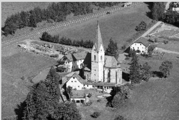
Die Laurenti-Kirche wurde um das Jahr 1453 erbaut und war bis 1830 die Pfarrkirche von Vordernberg.
