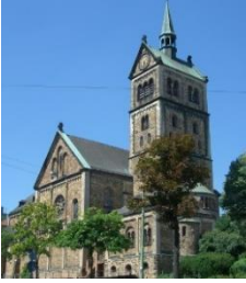
St. Maria Zentrales Pfarrbüro Kirchweg 71, 34119 Kassel
