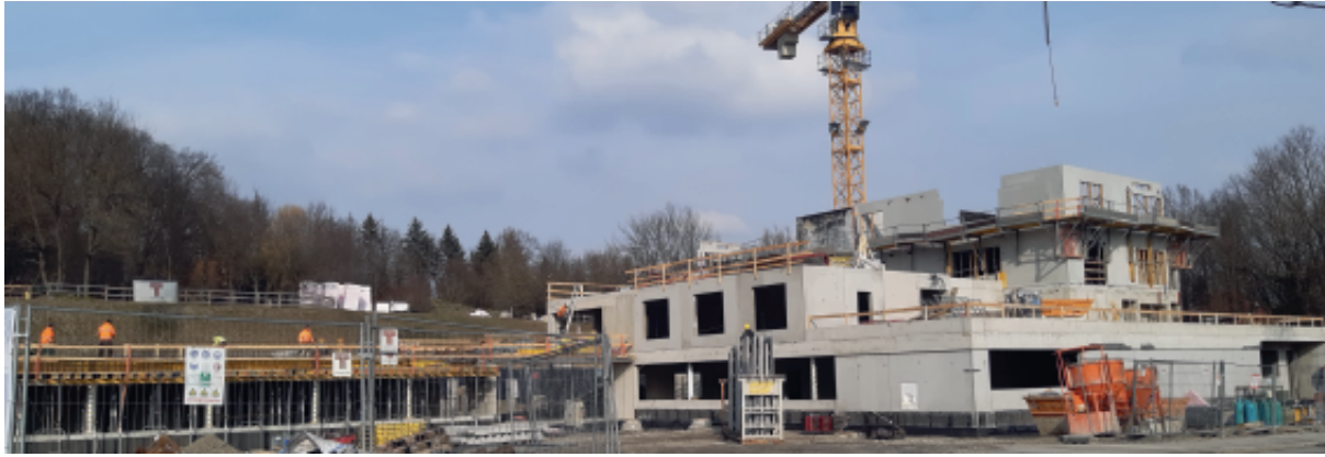
Baustelle Haus St. Klemens, Edenstraße, im Februar 2025
