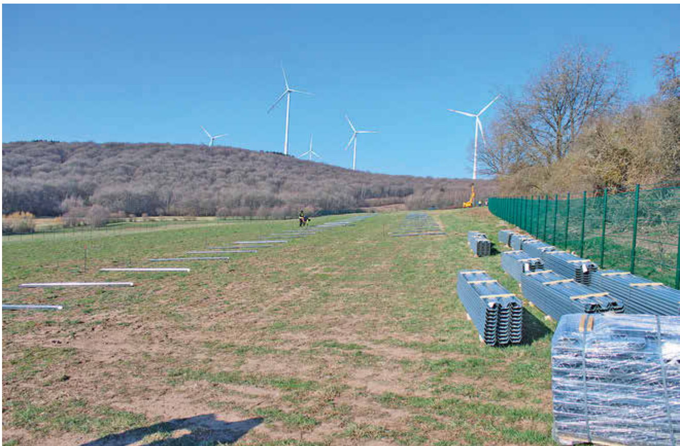
Die ersten Arbeiten zur Erweiterung der PV-Freiflächenanlage sind angelaufen / Foto: Gemeinde Nohfelden
