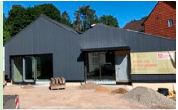
Ansicht des neuen Gemeindehauses von Westen
