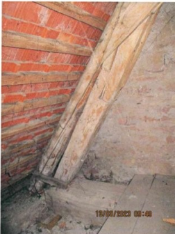
Abbildung 28: Sparrenfuß unzureichend gestoßen, Südseite Achse 1
