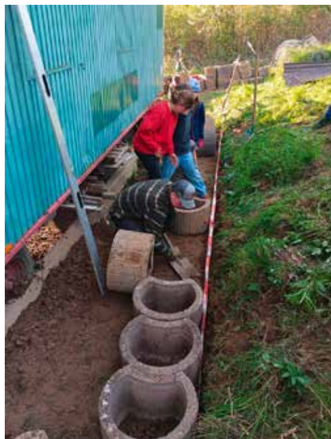
Die Befestigungssteine für die Terrasse vor dem Bauwagen werden gelegt.
