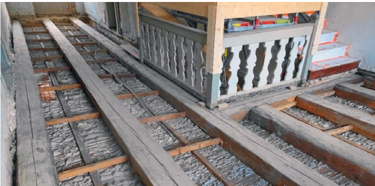
300 Jahre alte Balken im Treppenhaus kommen wieder zum Vorschein.
