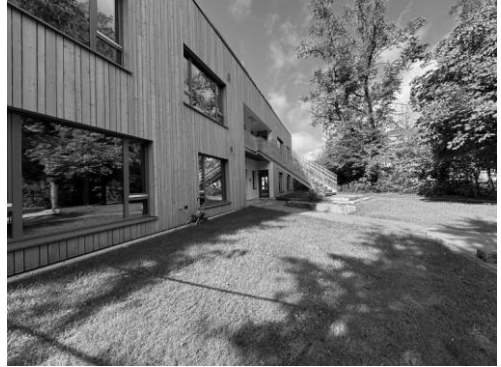
Rückseite Neubau Richtung Stadtpark
