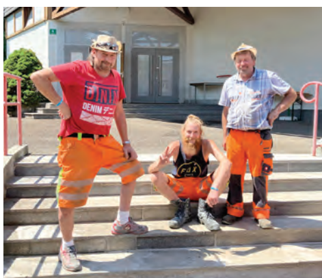
Reparaturarbeiten an der Stiege zur Kirche Niklasdorf
