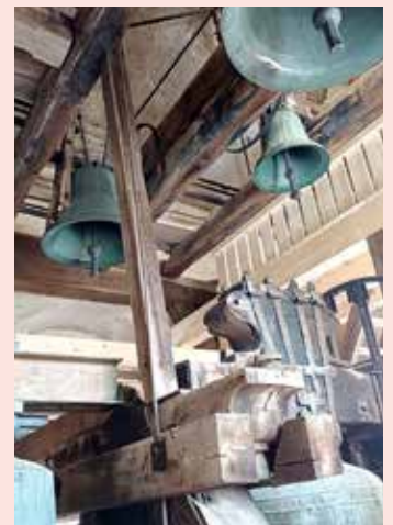
Blick in den Glockenstuhl
