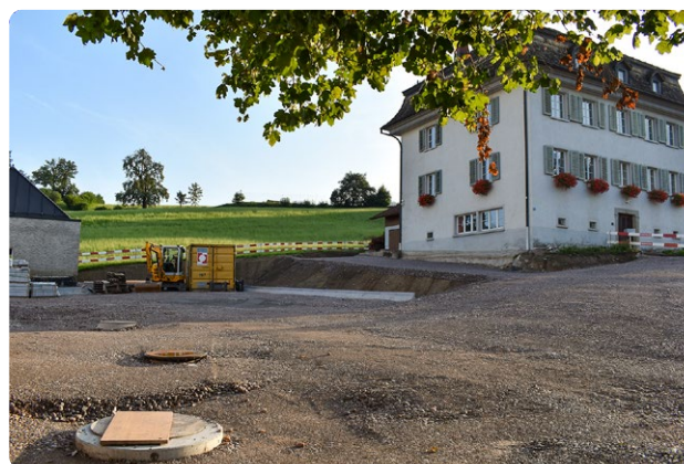
Pfarrhaus St. Gallenkappel: Hier entstehen neue Parkplätze.
