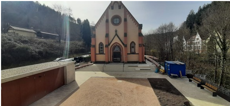
Die Außenanlage nimmt Gestalt an – langsam aber stetig
