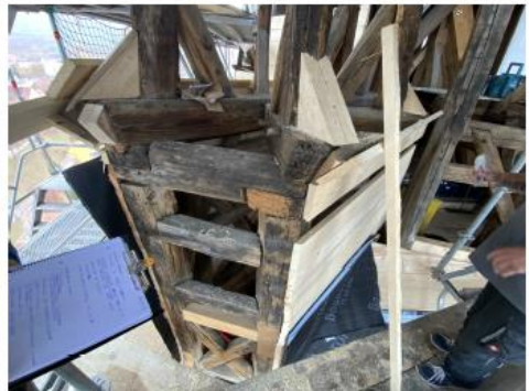
Fotos: Gratsparren Achse 13 erneuert (links) und Traufe/Aufschieber Turm 1 (rechts)
