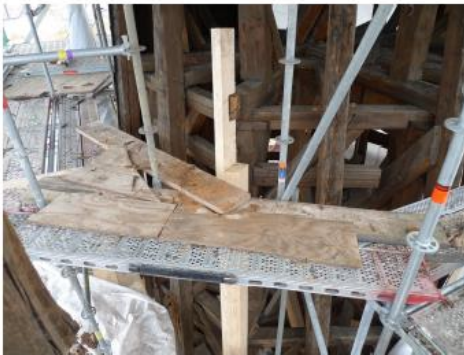
Fotos: Gratsparren Achse 13 erneuert (links) und Traufe/Aufschieber Turm 1 (rechts)
