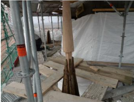
Fotos: Kaiserstiel neu Turm 2 Südost (links) und Turm 4 Nordwest (rechts) wiedereingebaut
