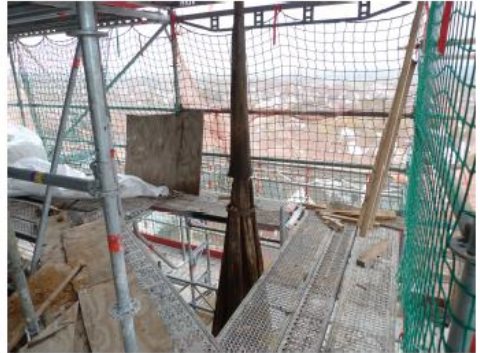
Fotos: Kaiserstiel neu Turm 2 Südost (links) und Turm 4 Nordwest (rechts) wiedereingebaut
